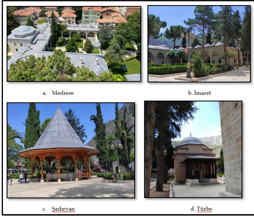
Şekil 9. II. Bayezid Külliyesi içerisinde bulunan yapılar (orijinal, 27.07.2022).
