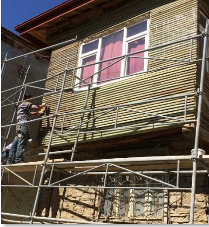
Fotoğraf 16. Yokuşbaşı Sokak cephe bağdadi kaplama (kişisel arşiv, 2018)
