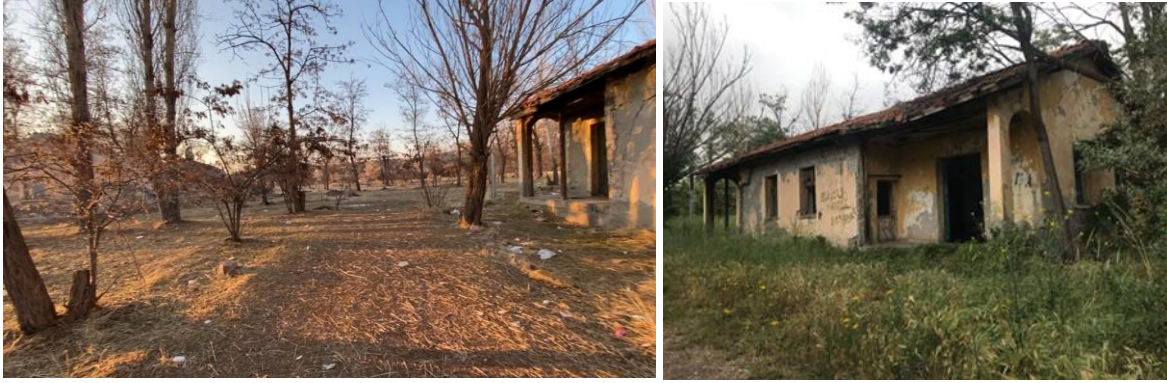
Şekil 15. Van Ernis Köy Enstitüsü yerleşkesinden Bir Görünüm
