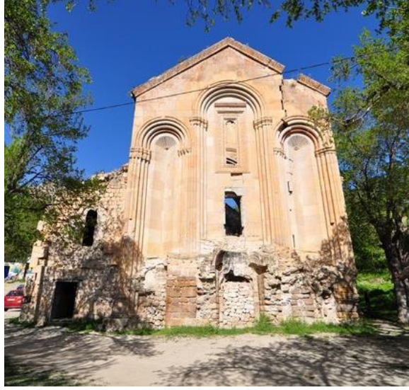
Görsel 27. İřhan Kilisesi, batı cephe, restorasyon öncesi genel görünümü.
