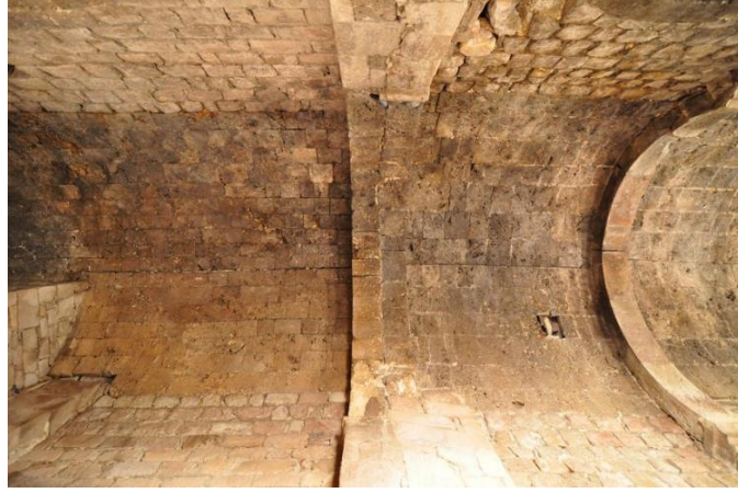
Görsel 10. Işhan Kilisesi, kuzeybatı mekanı, beşik tonoz örtüsü ve askı kemerleri detay görünümü.
