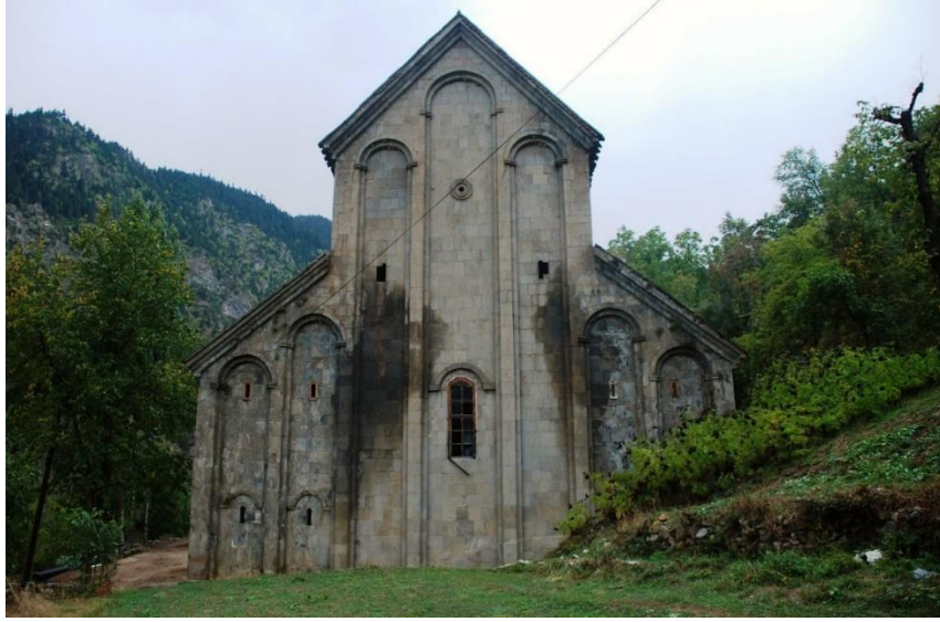
Görsel 32. Altıparmak (Barhal/Parhali) Manastır Kilisesi, doğu cephesi, genel görünüm, restorasyon öncesi (2014).
