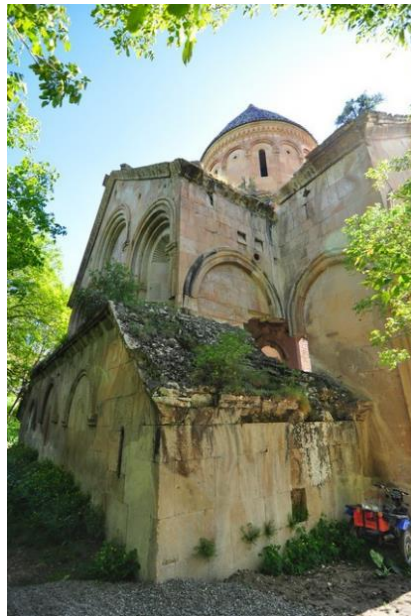
Görsel 11. Işhan Kilisesi, kuzey cepheden çatı sisteminin görünümü.
