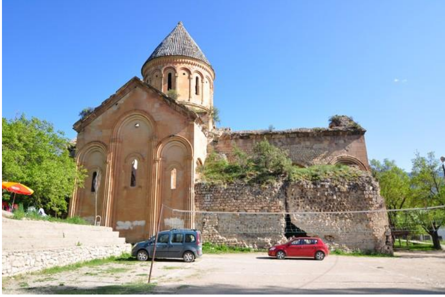
Görsel 30. Kilisesinin, kuzey cephe restorasyon öncesi genel görünümü.
