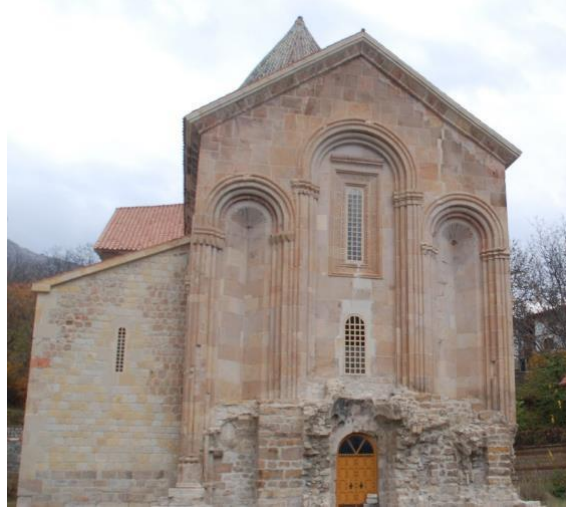
Görsel 28. İřhan Kilisesi, batı cephe restorasyon sonrası genel görünümü.
