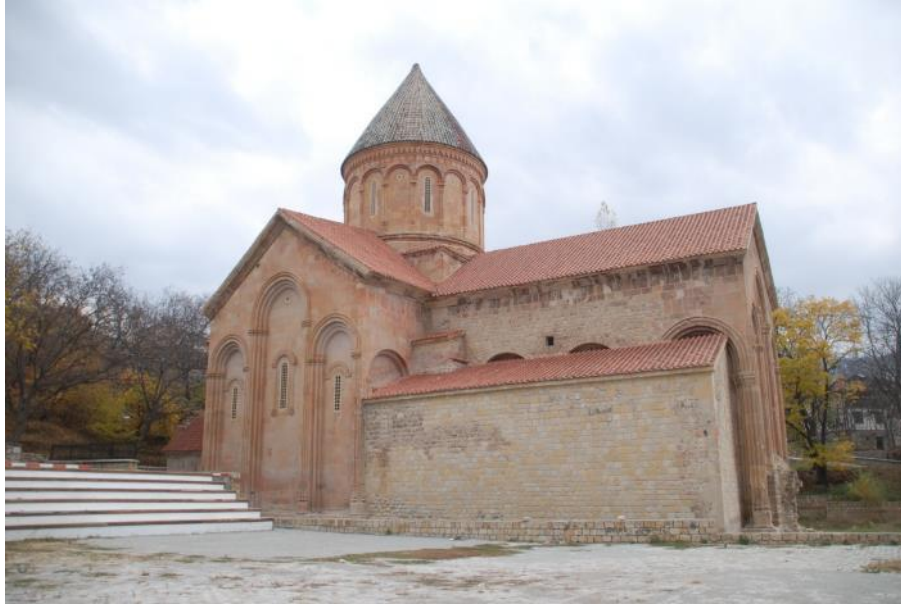
Görsel 31. Kilisenin, kuzey cephesi restorasyon sonrası genel görünümü.
