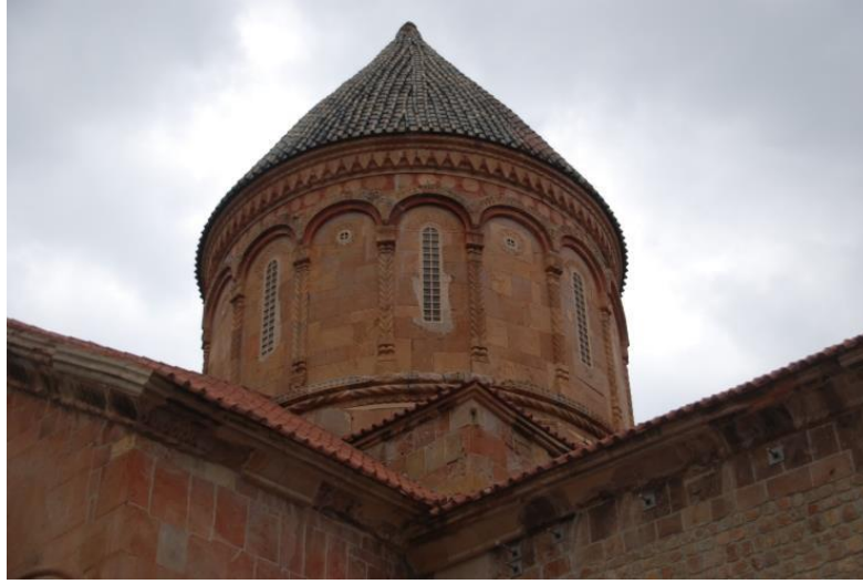
Görsel 12. İřhan kilisesi çatı sistemi restorasyon sonrası genel görünümü.
