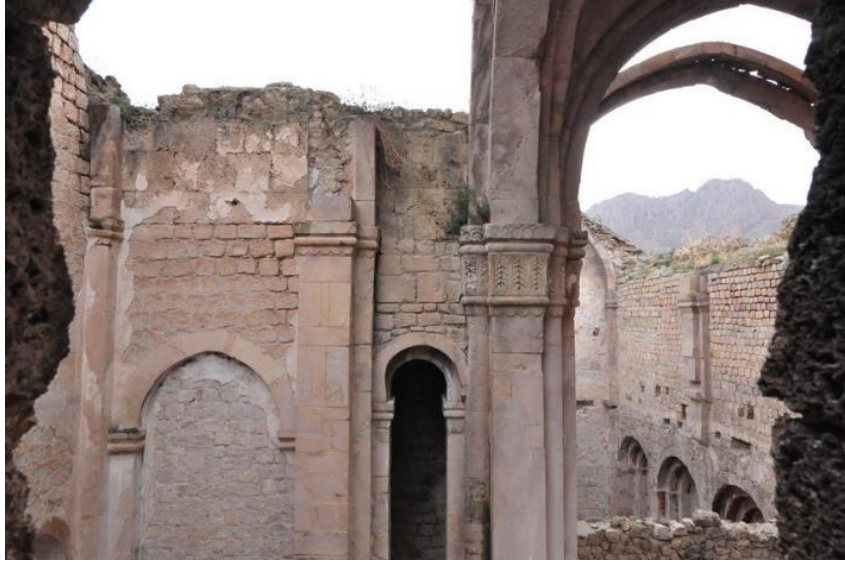
Görsel 14. İshhan kilisesi, güney haç kolu, batı duvarı üst örtü görünümü.
