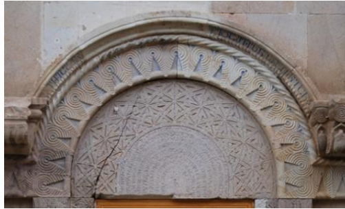
Görsel: 6. Güney cephe bezeme örnekleri.
