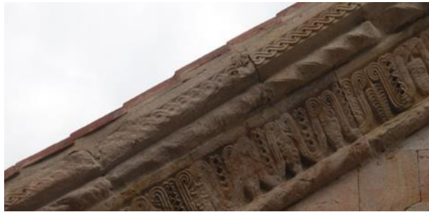
Görsel: 7. Güney cephe bezeme örnekleri.
