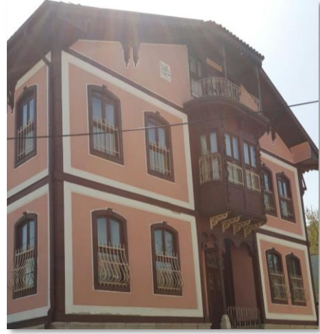
Fotoğraf 20. Eskikale Mahallesi ahşap saçak altı ve alın kornişi (kişisel arşiv, 2015)
