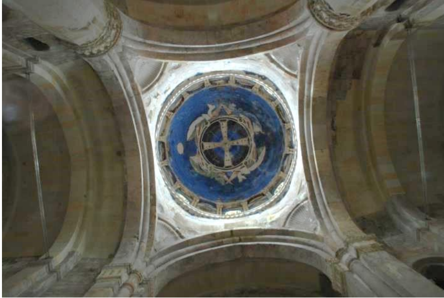
Görse 24. İřhan Kilisesi kubbe restorasyon sonrası görünümü.
