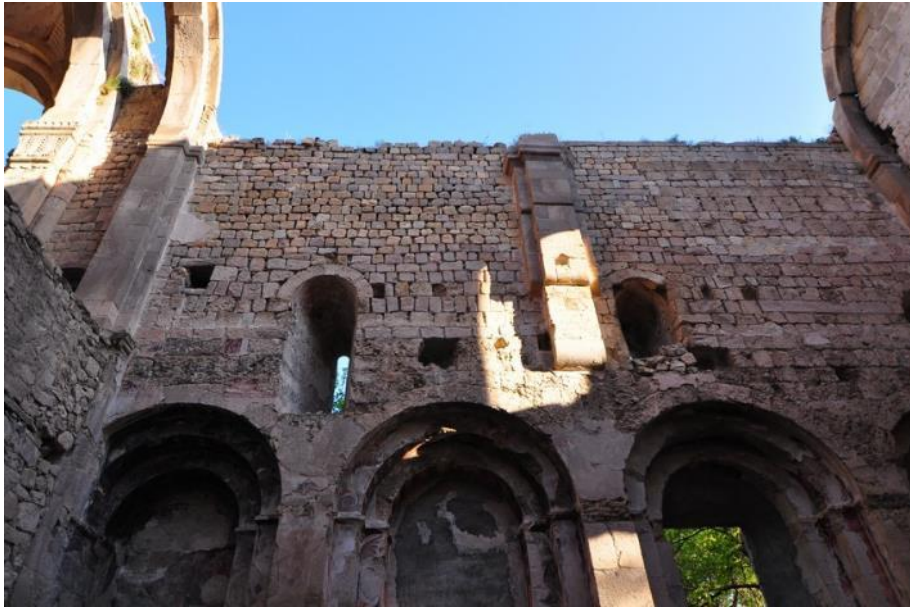
Görsel 13. İřhan Kilisesi, batı haç kolu güney duvarı, üst bölüm, tepe pencereleri ve ortada askı kemeri izi görünümü.
