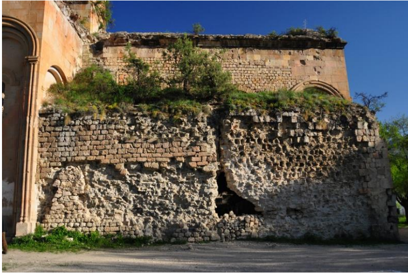
Gùrsel 8. İřhan Kilisesi kuzey cephesi, kuzeybatı mekânı ve batı haç kolu beden duvarı dıŐ görünümü (Restorasyon öncesi).
