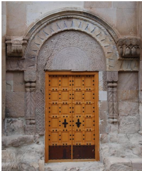
Görsel 29. Kilisenin, güney cephesinde yer alan kapı girişinin restorasyon sonrası ahşap kapı kanatları detay görünümü.
