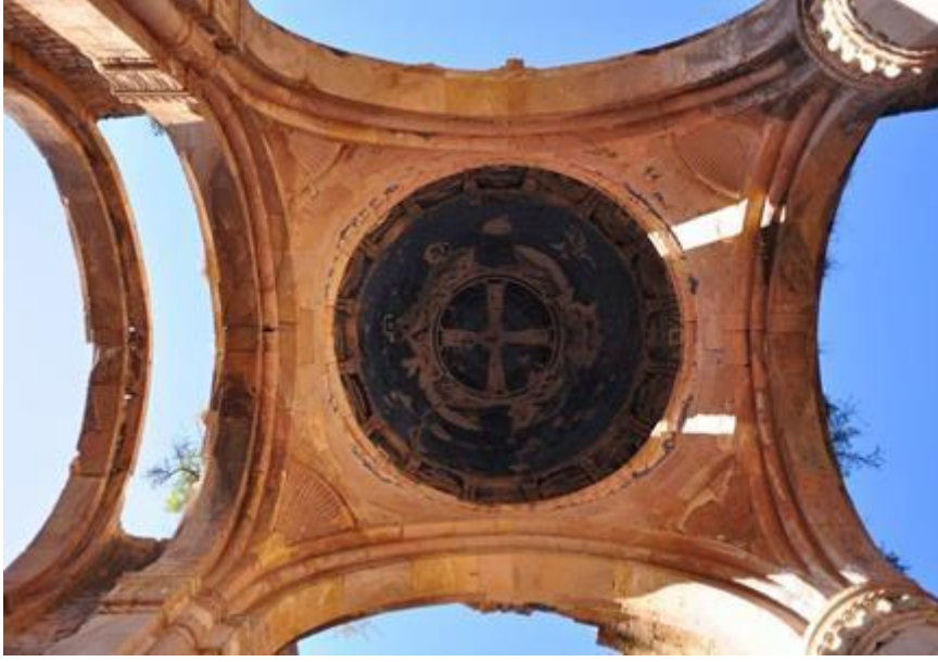
Görse 23. İřhan Kilisesi, kubbe, restorasyon öncesi bir görünüm.
