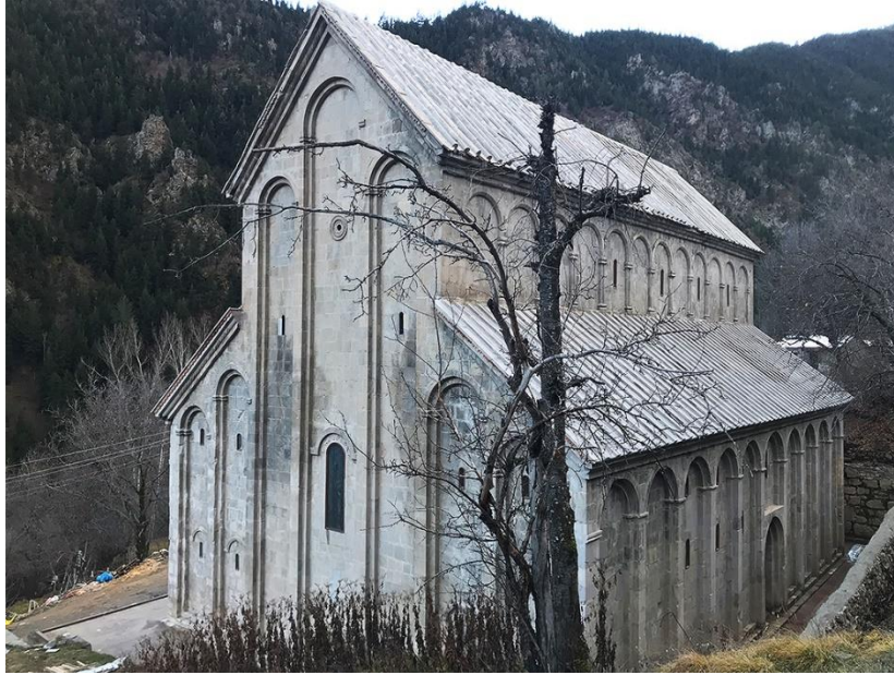
Görsel 33. Barhal Kilise-Camii, doğu ve kuzeydoęu cephesi, genel görünüm, restorasyon sonrası. Eriřim: https://gursoyrestorasyon.com.tr/projeler/artvin-barhal-kilise-camii , Eriřim Tarihi: 07.12.2023.
