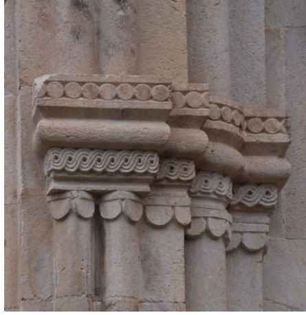
Görsel: 5. Güney cephe bezeme örnekleri.
