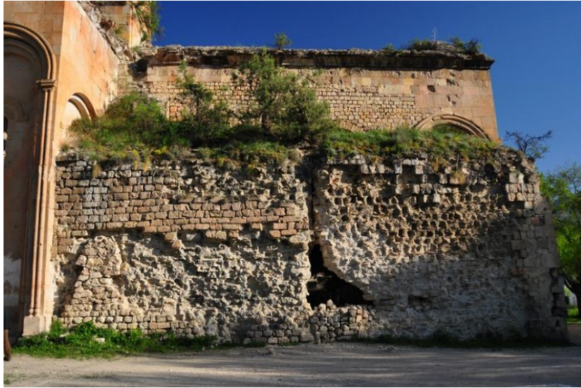
Görsel 8. İşhan Kilisesi kuzey cephesi, kuzeybatı mekânı ve batı haç kolu beden duvarı dış görünümü (Restorasyon öncesi).
