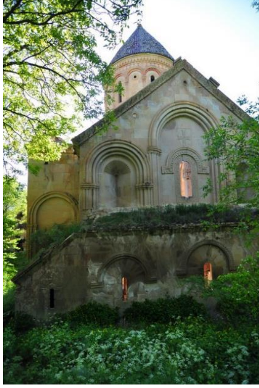
Görsel 19. İřhan Kilisesi, doęu cephe restorasyon öncesi genel görünümü
