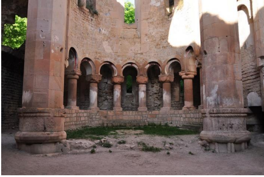
Görsel 25. İşhan Kilisesi, apsisi restorasyon öncesi genel görünüm.
