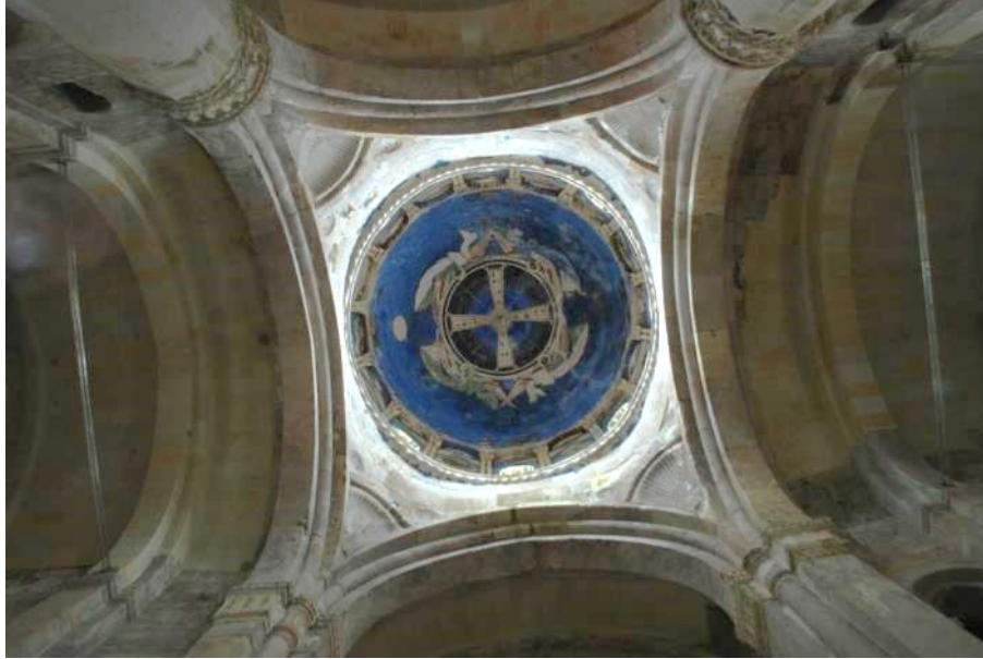
Görse 24. İřhan Kilisesi kubbe restorasyon sonrası görünümü.
