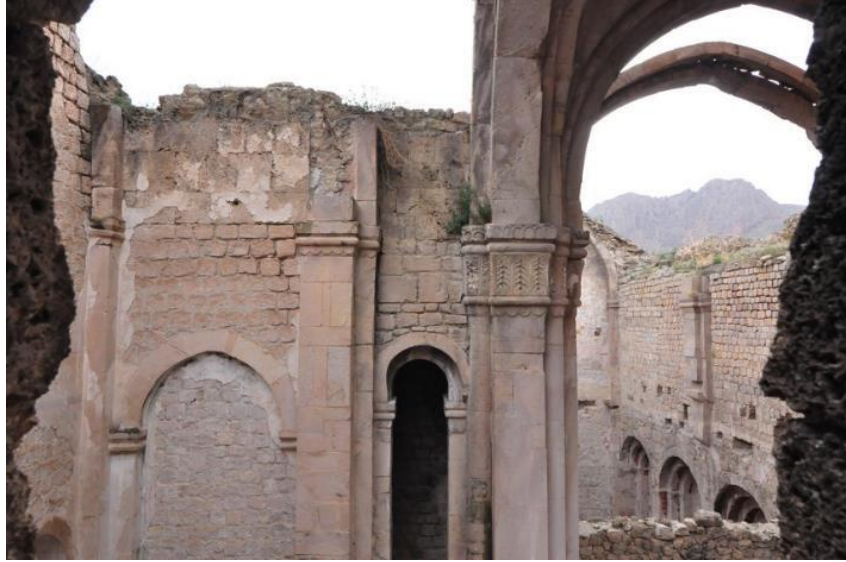
Görsel 14. İşhan kilisesi, güney haç kolu, batı duvarı üst örtü görünümü.
