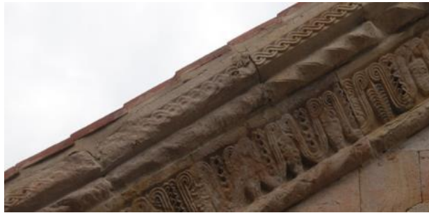
Görsel: 7. Güney cephe bezeme örnekleri.
